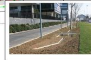
Noue sur quai de Seine
